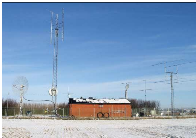
Die imposanten Antennenanlagen (u.a. Gruppen für 2 m und 70 cm sowie 4,5-m-Spiegel) von SK7MW in Südschweden (JO65). Foto: SK7MW
